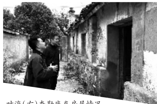
叶海(右)查勘废弃房屋情况。
