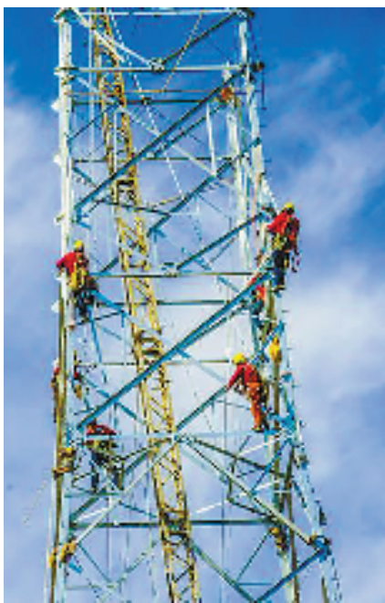
电力工人凌云施工 胡江丰
